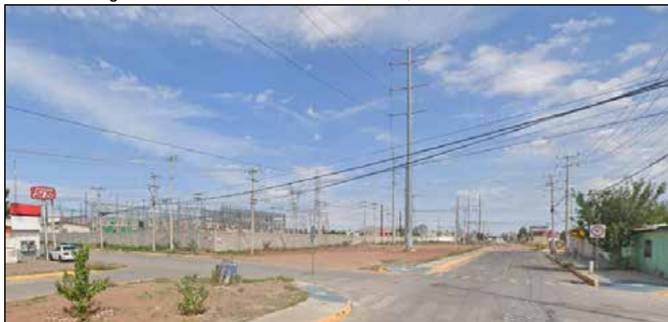
Imagen 50. Vista de red eléctrica 115 kva, en la C. Rodolfo Fierro.
