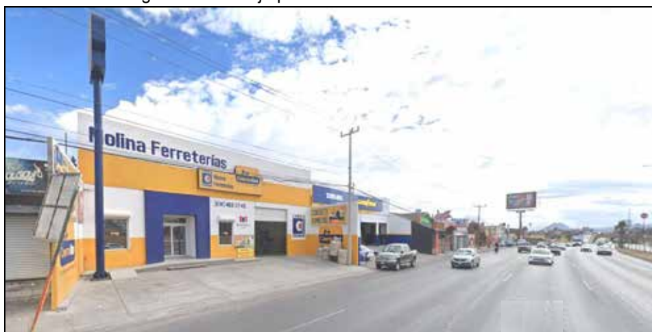
Imagen 53. Desalojo pluvial sobre la Av. Cristóbal Colón.
