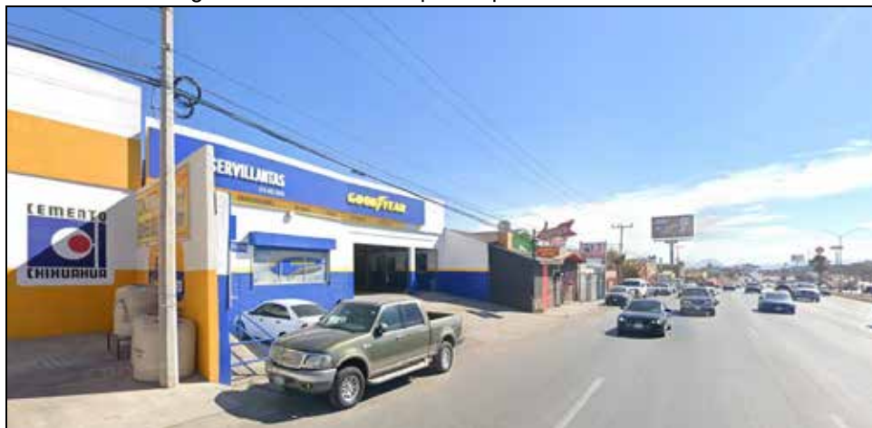
Imagen 56. Esguerramiento pluvial por Av. Cristóbal Colón.
