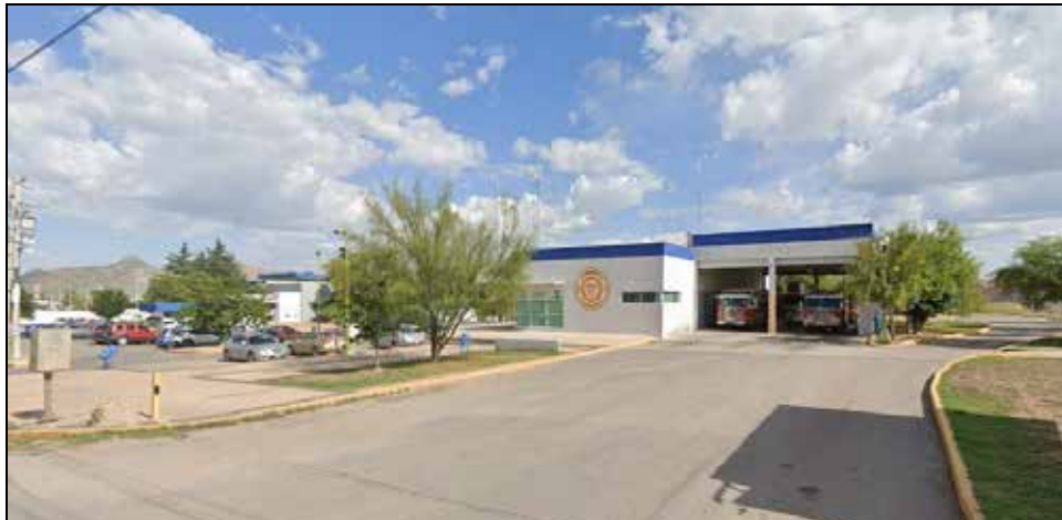
Imagen 31. Equipamiento de seguridad, Estación de Bomberos No. 3.
