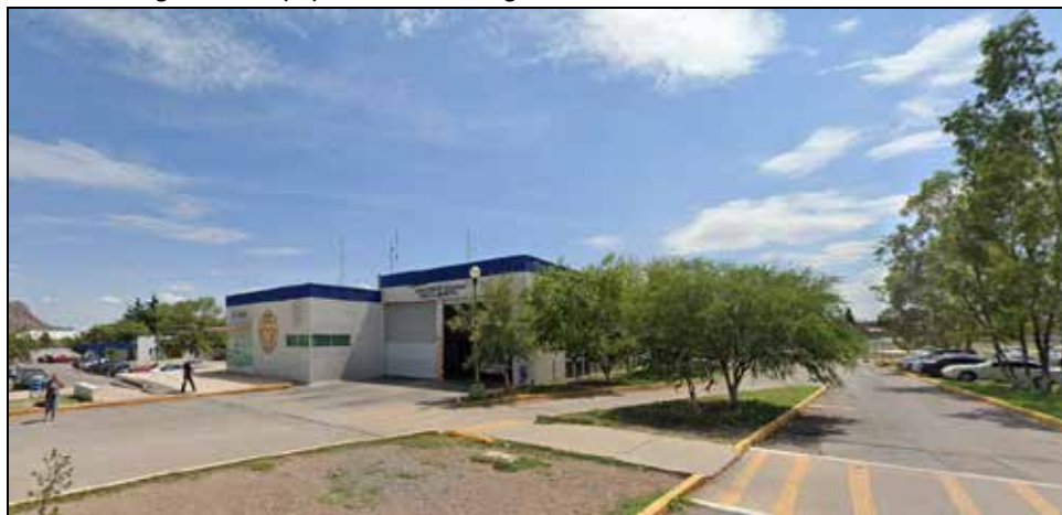
Imagen 61. Equipamiento de seguridad, Estación norte de Bomberos.
